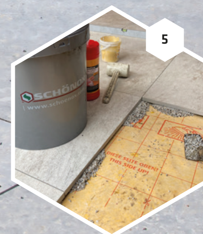
5 Mittels Gummihammer und Wasserwaage die Fliesen oder Platten ausrichten.
