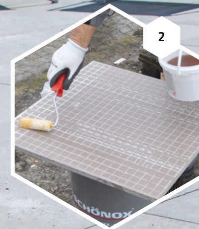
2 Kontaktschicht mit SCHÖNOX EP DRAIN pur auf die Fliesenrückseite aufrollen.
