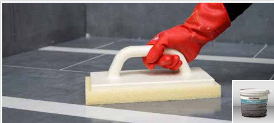
De voegen glad wassen en de oppervlakte met een spaan met hydro-spons of alleen een hydro-spons reinigen. Voor hardnekkige harsresten kan SCHÖNOX EPOXY CLEAN als hulp worden gebruikt.
