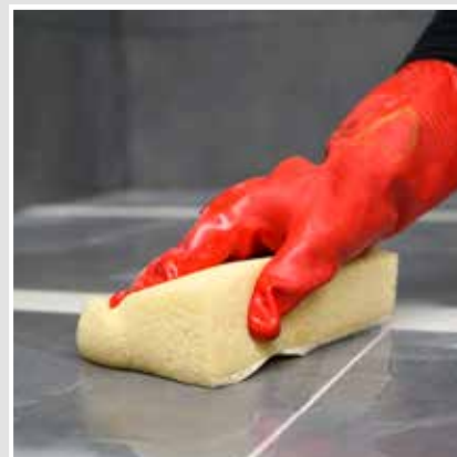
Materiaalresten met een hydro-spons en koud water emulgeren.
