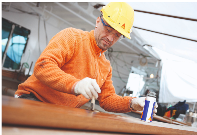
Figuur 12 Primer aanbrengen met een kwastje
