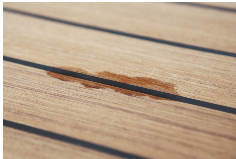
Figuur 1 Detailopname van een beschadigde teakvoeg
