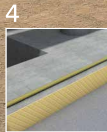
4 SikaFuko® VT- injectieslang
