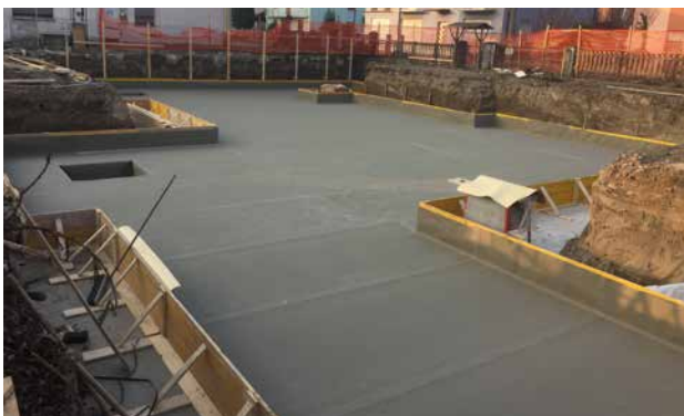
Typische toepassing van SikaProof® A+ op een werkvloer.
