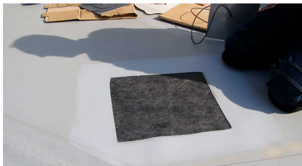
Na het reinigen een stuk uit het kunststof afdichtingsmembraan snijden.
