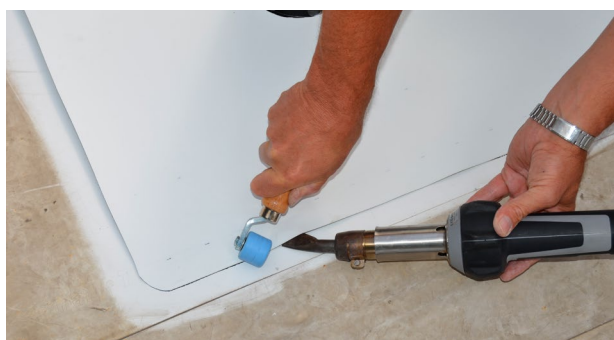
Het oppervlak passend maken en vastlassen.
