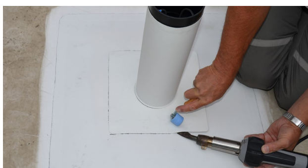
Dichtlassen van de Sika® prefab doorvoeromkleiding en vervolgens nacontrole uitvoeren.
