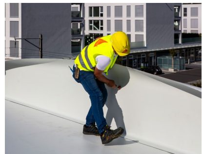
3. Bevestig het zelfklevende membraan.
