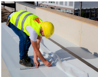
2. Teken de bovenkant van de opstand af.
