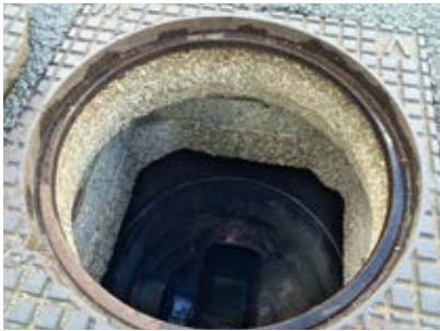
Mangat voor het riool na slechts 3 jaar gebruik en aangetast door biologische corrosie.
