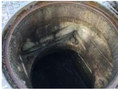
Mangat voor hemelwaterafvoer na 3 jaar gebruik zonder aantasting.
