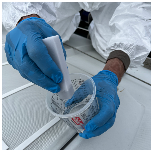
Sika® MultiPrimer Marine aanbrengen met een melamine schuimsponsje (Sika® Cleaner PCA)
