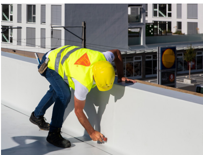
4. Druk het membraan aan met een geschikte aandrukrol
