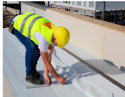
2. Teken de bovenkant van de opstand af
